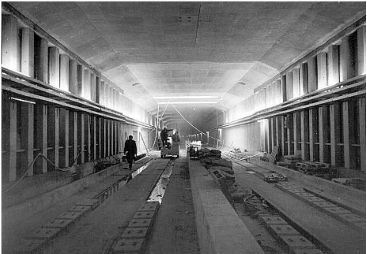
De Schipholtunnel tijdens de bouw
