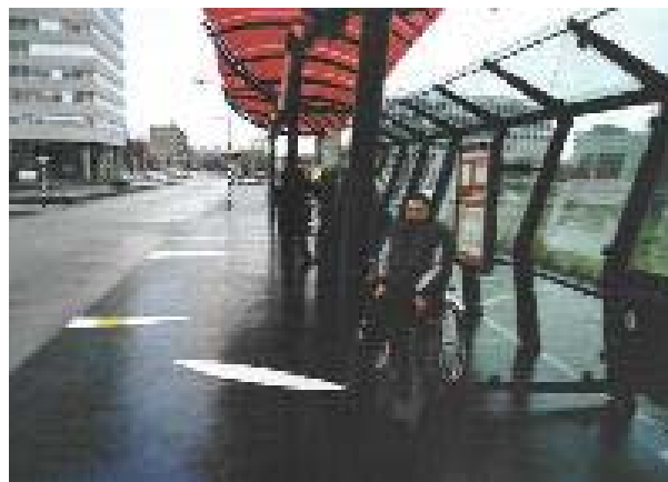
Een van de haltes van de busbaan Zuidangent in Haarlem.
